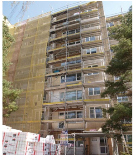
Obr. 13. Probíhající stavba na budově s hnízdištěm rorýsů ve Starém Lískovci (Brno).. 12. 4. 2018. © K. Horák
