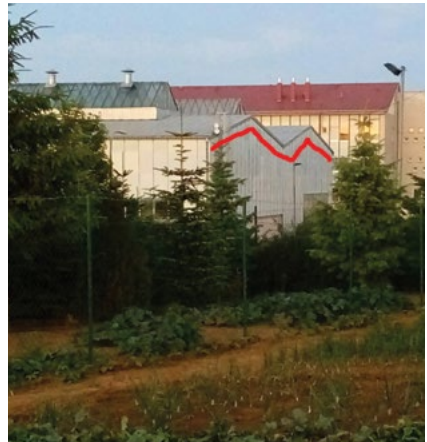
Obr. 8. V obvodovém plášti plechové haly v areálu odtahové firmy na Pražské ulici v městské části Brno-Bosonohy hnízdilo více jak 10 párů rorýsů. Srpen 2017. © L. Rozsypalová
